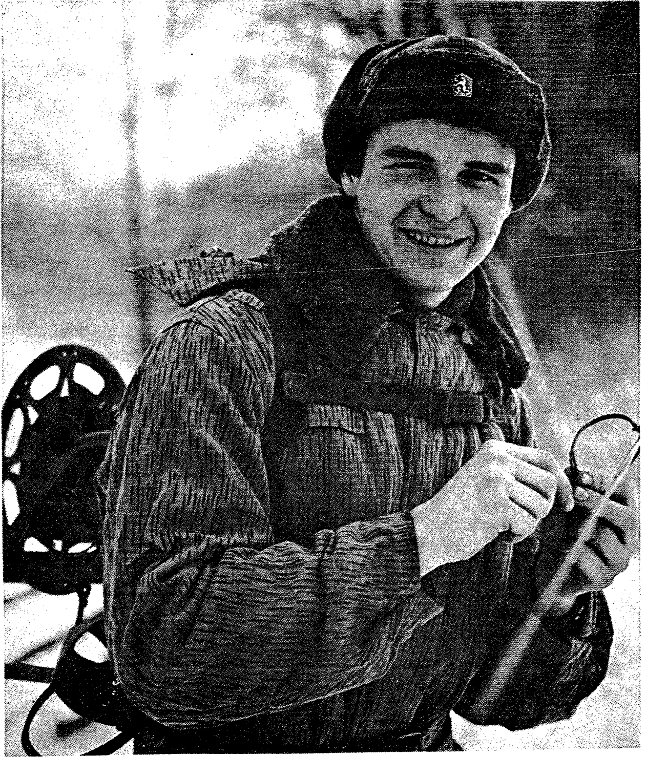
Stavba linkového spojení Laying wire for communications
